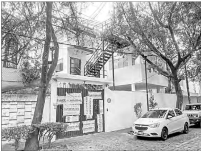
▲ La casa ubicada en la colonia Chimalistac fue clausurada por diversas violaciones, por eso la alcaldía Álvaro Obregón impuso multas a los propietarios. En el caso de la
