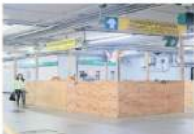
Este martes, trabajadores colocaban piso en la zona de transbordo de la Línea 8 a la 12.
