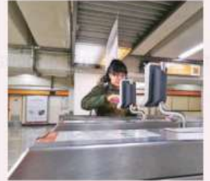
Los equipos validadores de tarjeta funcionaron adecuadamente SCT METRO
