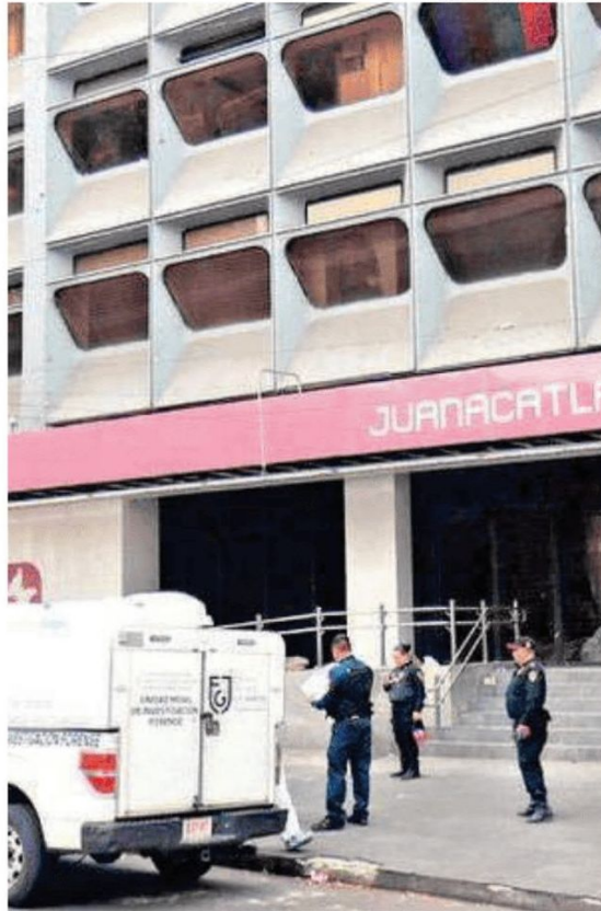
El hombre estaba acostado en la rampa de ascenso y descenso con una cobija y cartones encima
