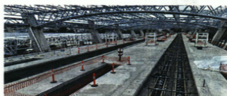
La terminal permitirá conectar el Tren Interurbano y la líneas 1 y 12 del Metro.
