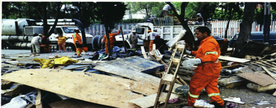
DESMONTAN VIVIENDAS. Los trabajadores removieron los espacios habilitados por las personas en tránsito.
