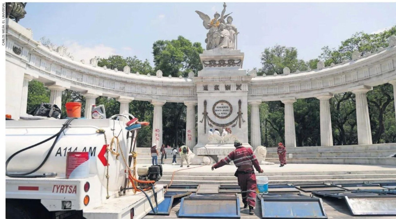
Trabajadores de la Secretaría de Obras y Servicios realizaron labores de limpieza en el Hemiciclo a Juárez y volvieron a colocar las vallas metálicas azules para resguardar el monumento; algunos visitantes lamentaron que lo dañen y que por ello vuelva a ser "bardeado".
