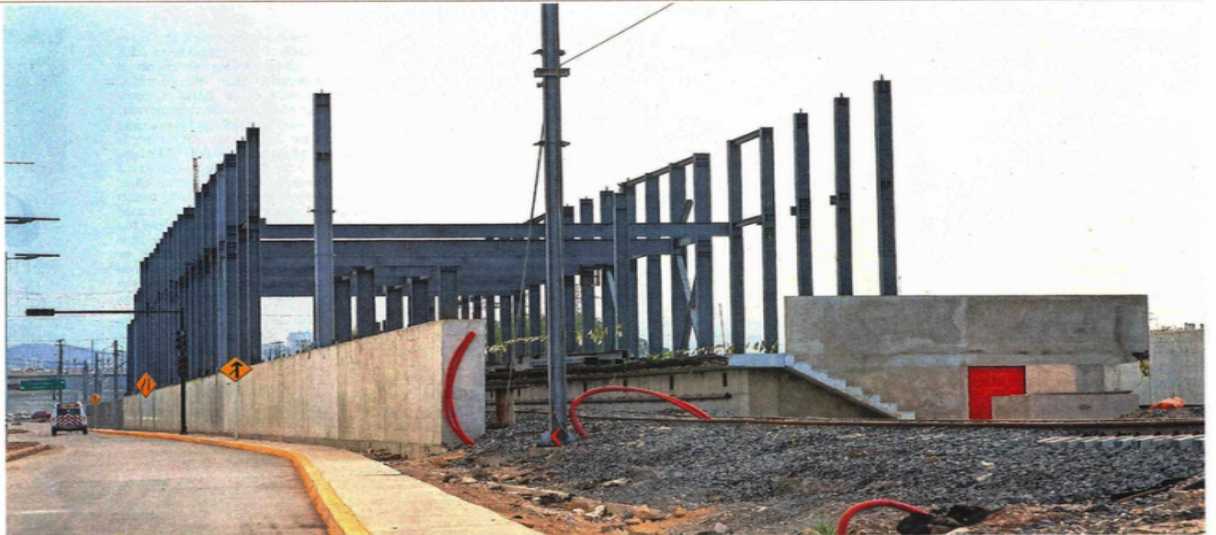
Pobladores de Tultepec tienen detenida la obra en diferentes puntos, pues quieren obras adicionales al proyecto original y de mitigación.
