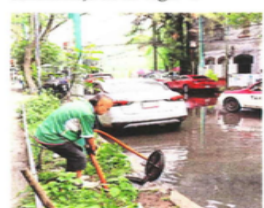
La alcaldía realizó labores de desazolve en puntos críticos.
