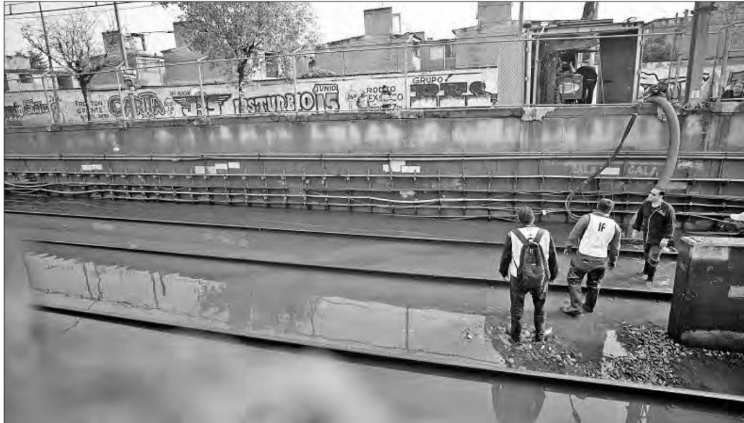
▲ La línea A del Sistema de Transporte Colectivo permaneció cerrada debido a la inundación de las vías provocada por la fuerte lluvia de la tarde y la noche del lunes. Foto Alfredo Domínguez
