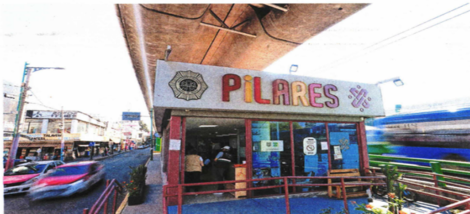
En Ermita Iztapalapa se ubica uno de los módulos de la policía capitalina que fue convertido en una unidad Pilares.
