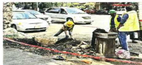
Las palmeras comenzaron a ser retiradas el martes por la noche; los trabajos continuarán los próximos días.
