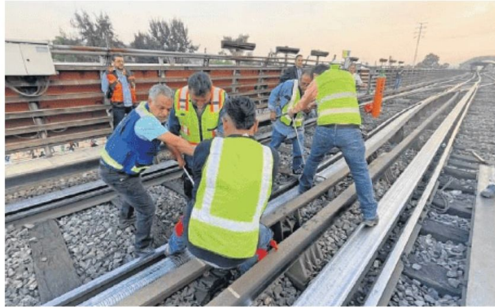
Personal del Metro revisó el sistema de vías de las estaciones afectadas. Las labores continuaron por la noche.
