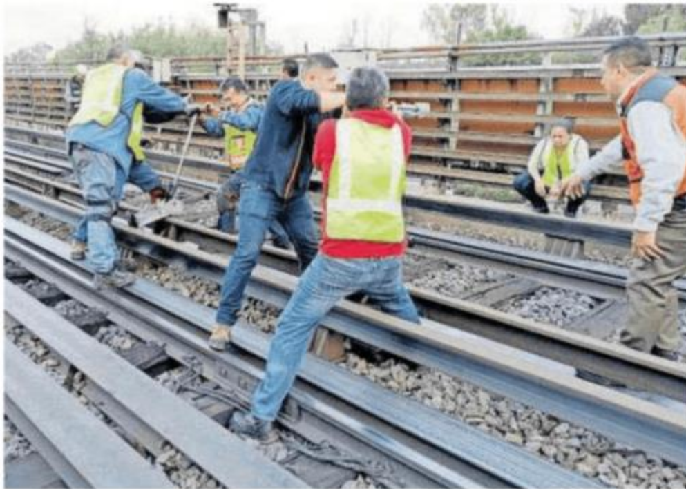
El personal del Metro ajustó el riel que se curvó
