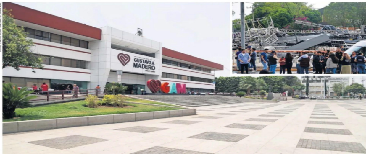
Tras los peritajes, la estructura colapsada fue retirada en su totalidad durante la madrugada del viernes; la explanada de la alcaldía Gustavo A. Madero quedó vacía.
