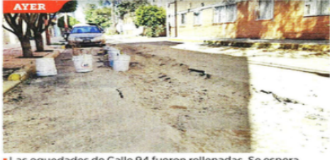
Las quedades de Calle 94 fueron rellenadas. Se espera que la siguiente semana se realice la repavimentación.
