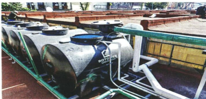
En el techo se colocan canaletas que llevan el agua de lluvia hasta estos tinacos de prefiltrado.
