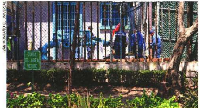
El agua del pozo Alfonso XIII, ubicado en Álvaro Obregón, fue extraída para proceder a la limpieza de las instalaciones.
