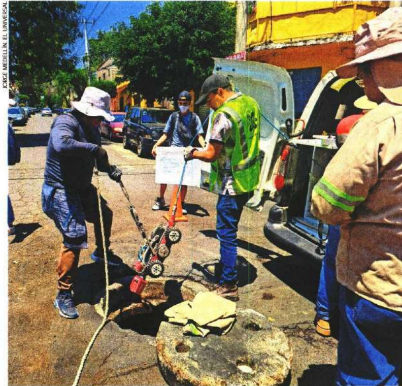
Personal del Sistema de Aguas de la Ciudad de México ingresó una cámara de inspección de circuito cerrado para revisar las tuberías aledañas al pozo.
