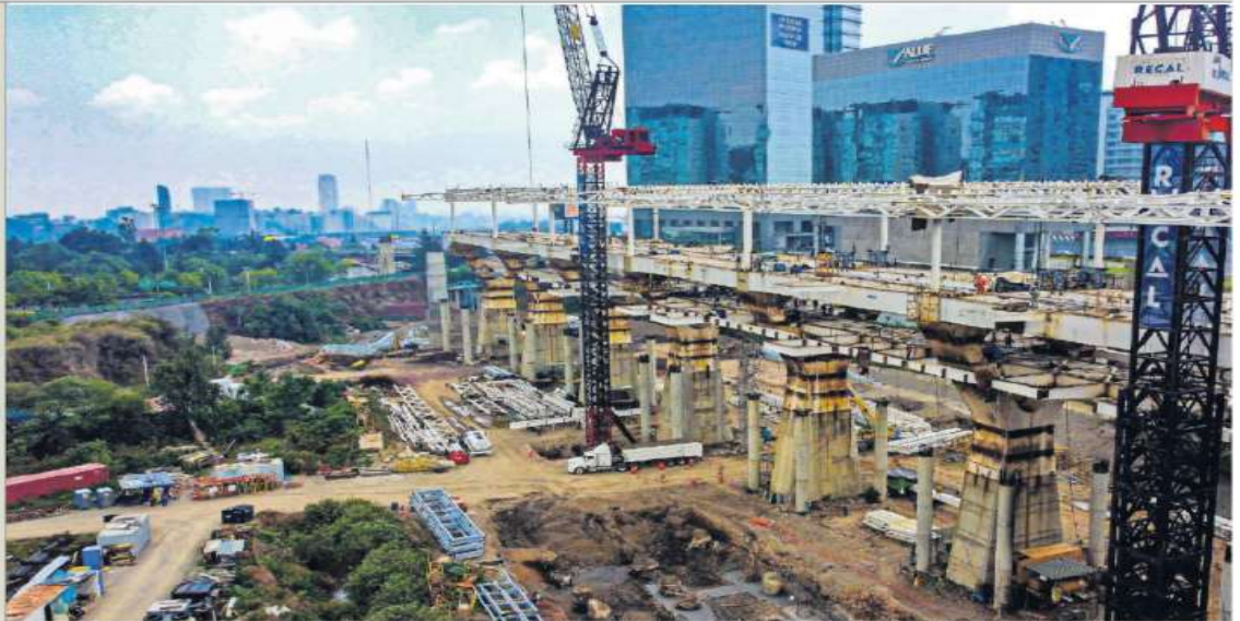
El Tren Interurbano se comenzó a construir en 2014. Tras un periodo de incertidumbre, la edificación en la Ciudad de México se retomó en 2020.
