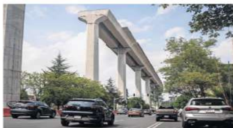
En la avenida Vasco de Quiroga se observa que aún faltan dovelas.
