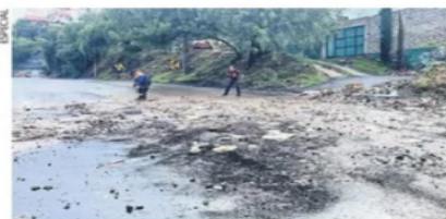
Un desprendimiento de piedras y tierra se registró en avenida Insurgentes Norte, a la altura de Indios Verdes.
