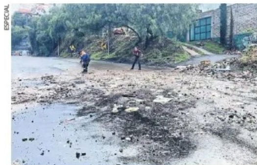
Un desprendimiento de piedras y tierra se registró en avenida Insurgentes Norte, a la altura de Indios Verdes.
