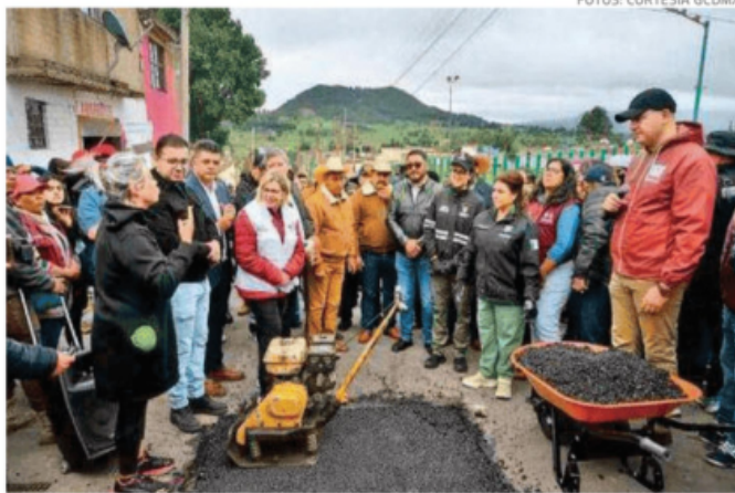
Clara Brugada encabezó la jornada Obras son Amores para la Transformación
