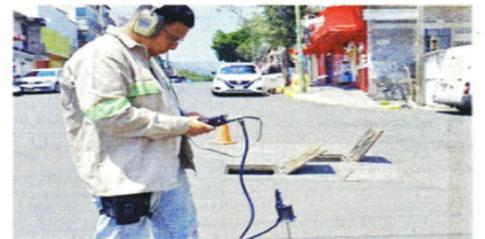
Además de una cámara de alta resolución, el equipo cuenta con un geófono, que permite detectar la fuga con exactitud.
