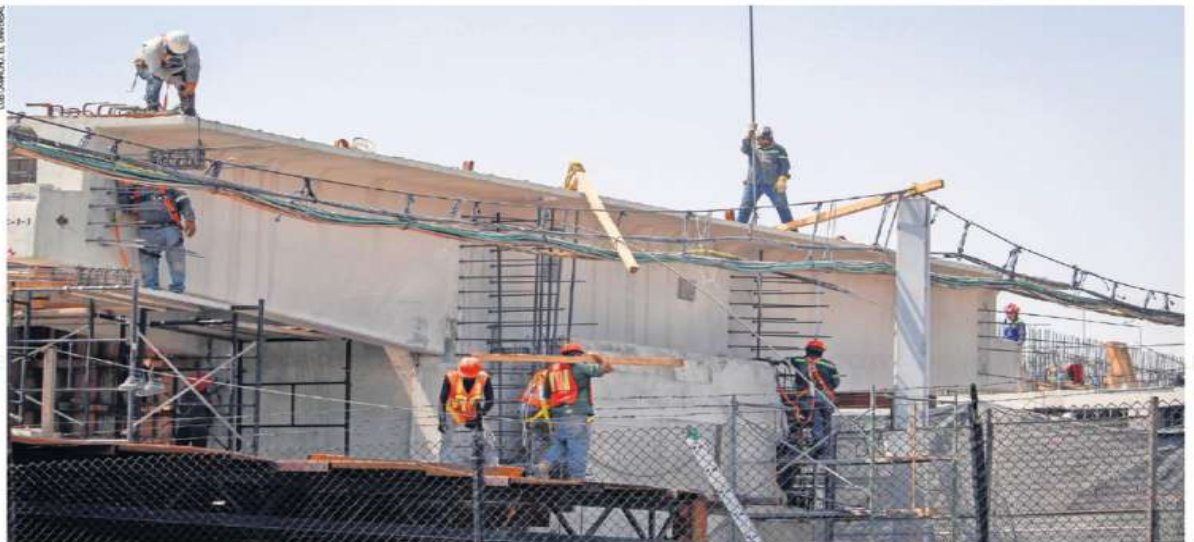
Trabajadores de la Secretaría de Obras reconstruyen el tramo elevado hacia Pantitlán, para evitar el hundimiento registrado en esta parte.
