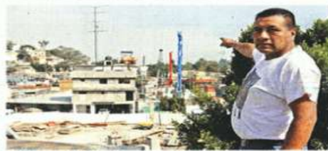
Vecinos de El Capulín explican los daños de las obras por el Tren Interurbano.
