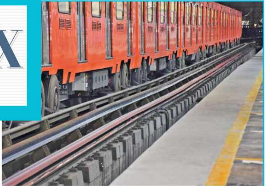
• REMOZAR. Se van a intervenir 300 bloques de concreto que sostienen la vía.
