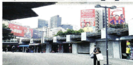
■ Lonas publicitarias se encuentran colgadas sobre muros de edificios, lo cual está prohibido por la normatividad.
