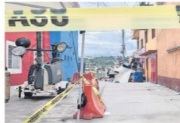
La explosión dejó afectaciones en cinco lotes de vivienda y perjudicó a 15 familias de la zona, dijo el alcalde Javier López Casarín.
