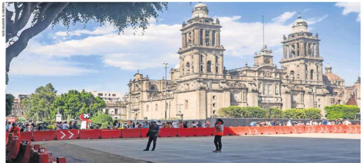
Para concluir las obras en tiempo, personal de la Sobse trabaja de forma permanente las 24 horas y confina la zona todos los días para realizar su labor.
