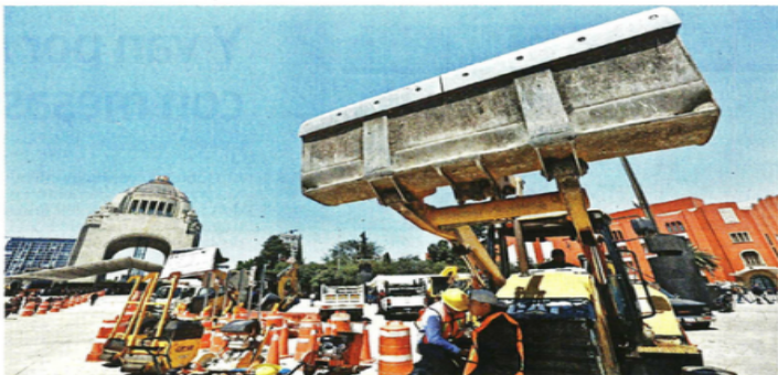
MAQUINARIA PESADA. La CDMX informó que se sumaron 5 mil trabajadores para realizar las labores de reparación del asfalto, con el objetivo de concluirlos antes de las lluvias.
