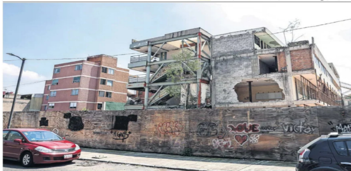
Tras nueve años del sismo de 2017, el predio donde se encontraba el Colegio Enrique Rébsamen está abandonado y bajo resguardo policial; vecinos aseguran que han visto rapiña en el lugar.
