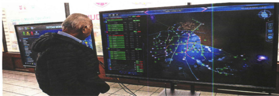
En una de las pantallas es posible observar las condiciones del drenaje profundo.
