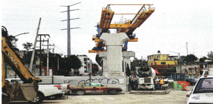
OBRAS A MEDIAS. Aunque las autoridades prevén concluir el tramo pendiente del Tren para diciembre, las obras se encuentran detenidas a la altura de El Capulín.
