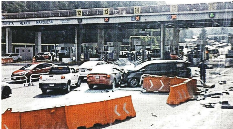
■ La Caseta de La Venta, en el kilómetro 24 de la México-Toluca, resultó con daños.
