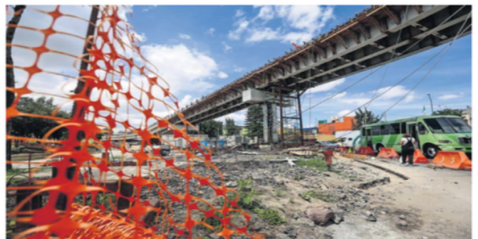
La Secretaría de Obras y Servicios señaló que los puentes que permitirán la incorporación del tramo elevado con el trayecto a nivel de piso tienen un avance de 94%.
