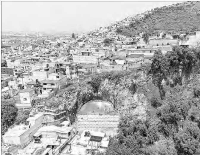
▲ Casi la totalidad del Peñón Viejo está cubierto con casas, algunas de las cuales han sido reforzadas por la caída de rocas de años anteriores, mientras en la barranca que
