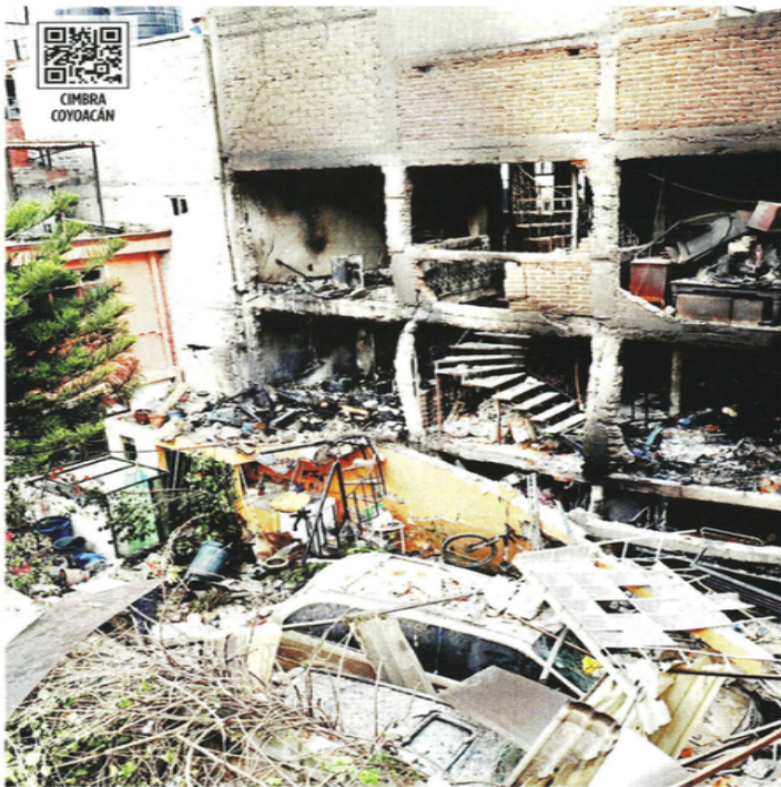
ARRASA CON VIVIENDA. Tras la fuga de gas, se registró la explosión y un incendio en la vivienda ubicada en Cerrada Duraznotilla, en la Colonia Los Reyes.
