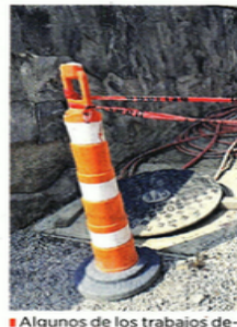
Algunos de los trabajos debieron concluirse en octubre.
