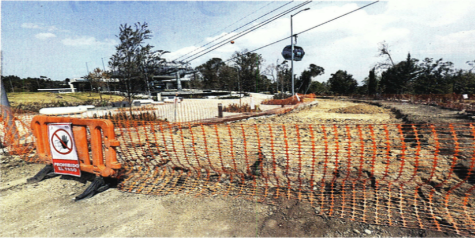
EN OBRAS. En la Cuarta Sección del Bosque de Chapultepec los usuarios se encuentran aún con trabajos en proceso.
