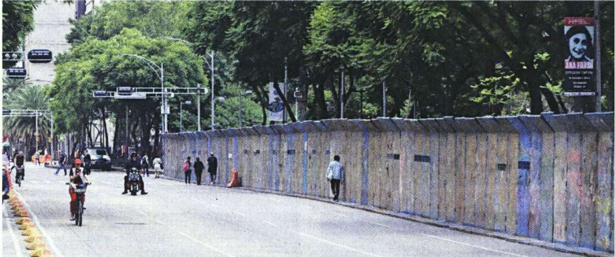
Tan súbita fue la instalación del cerco metálico, que no se contempló delimitar espacio para peatones.
