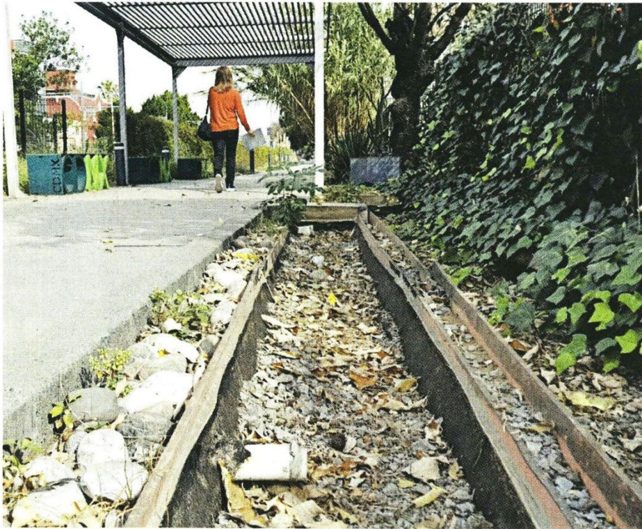
SIN UNA GOTTA. Las canaletas del biodigestor se encuentran bloqueadas con azolve.
