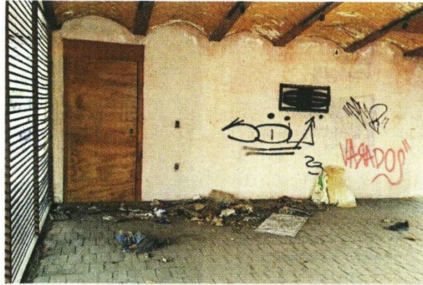
Un foro metálico quedó sin uso.
