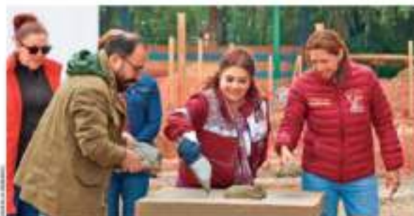
INICIO. La jefa de Gobierno, Clara Brugada, colocó la primera piedra de la obra que estará en la alcaldía Venustiano Carranza.
