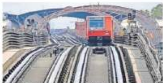
Los trabajos se realizarán por las noches y se espera que concluyan el 31 de octubre. Al momento ya se encuentran en fase de estudio.
