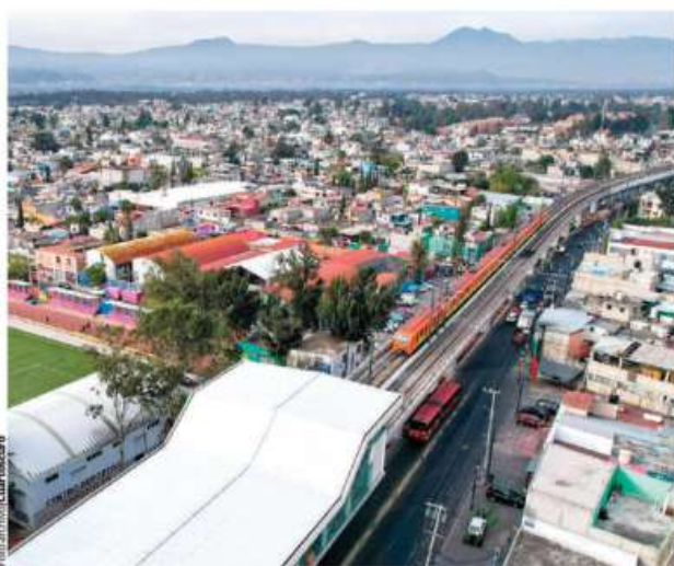
VISTA aérea de un tramo de la Línea 12 que va de Mixcoac a Tláhuac.
