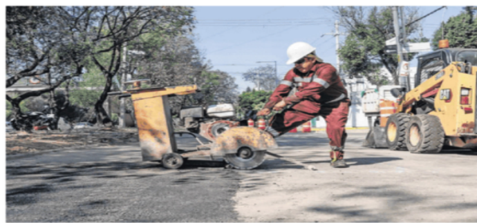
El Bachetón arrancó con 150 cuadrillas y un total de mil 500 trabajadores, pero la intención es tener 500 cuadrillas laborando, informó el titular de Obras y Servicios.
