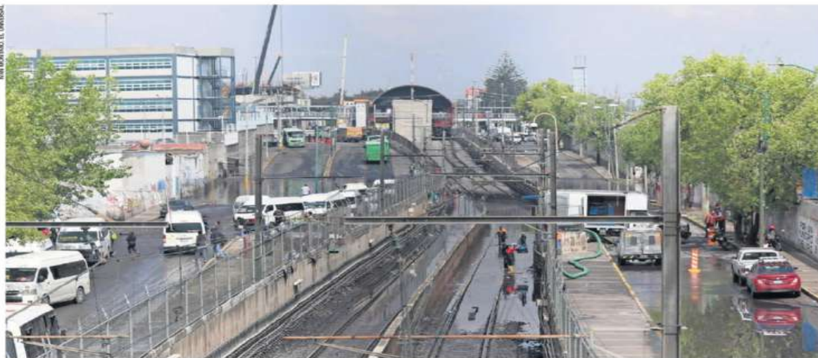
El agua de lluvia se estancó en el cajón de vías del tramo La Paz-Los Reyes, en la Línea A del Metro, por lo que personal del Sistema de Transporte Colectivo trabajó en el retiro del líquido y limpieza de la estructura para reanudar el servicio.
