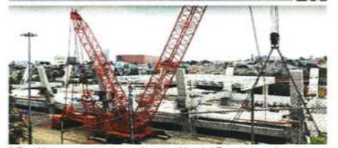
En el lugar, se construye la estación del Tren Interurbano.
