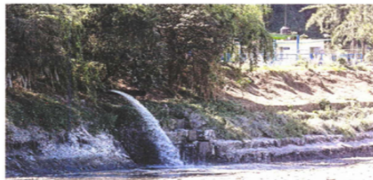
En la presa se juntan toneladas de excremento de los habitantes de miles de casas y desarrollos inmobiliarios que de forma ilegal vierten sus descargas.
