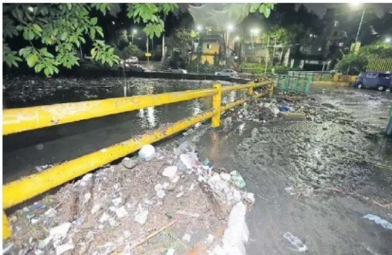
Tras labores de personal de emergencia, la presa conocida como San Francisco, del Río Becerra regresó a su nivel.
